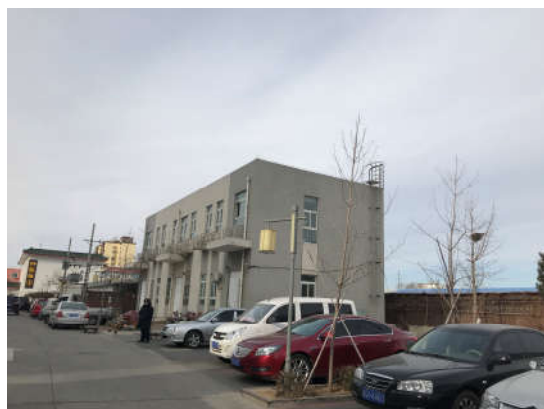
新建变配电室
