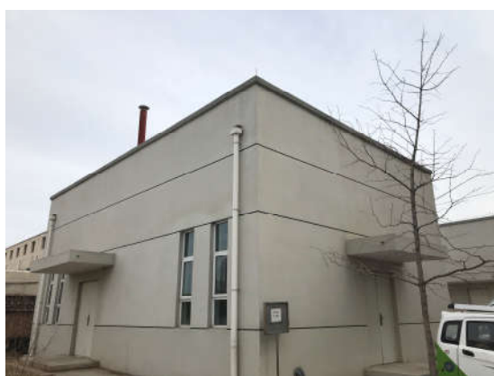
新建污水处理站
