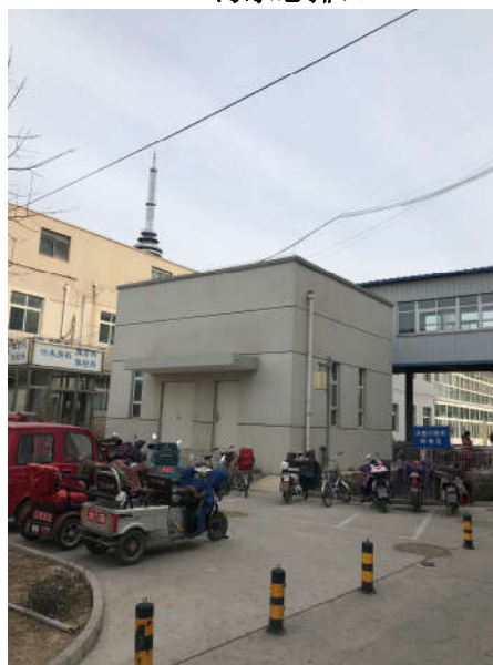
新建中心供氧站
